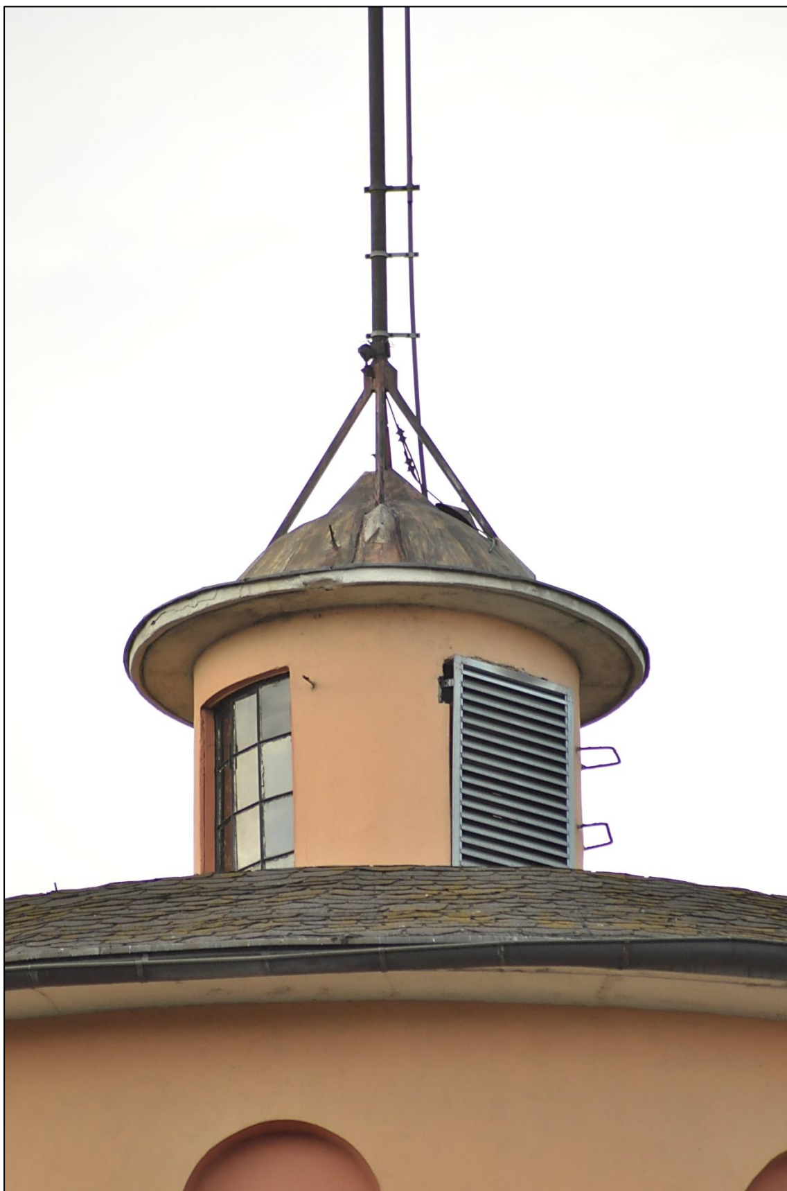
Fot. 15. WIEŻA CIŚNIEŃ, latarnia na głowicy – widok od pld.- zach. Widoczny fragment dachu na kopule głowicy wykonany z gontu papowego zniszczone, pokryte warstwą porostów. pokrycie dachowe wieżyczki wykonane z blachy posiada dziwaczny kształt kopuły zakończonej stożkiem gdzie pierwotnie forma daszku oparta była na stożku a iglica była przedłużeniem stożka.
