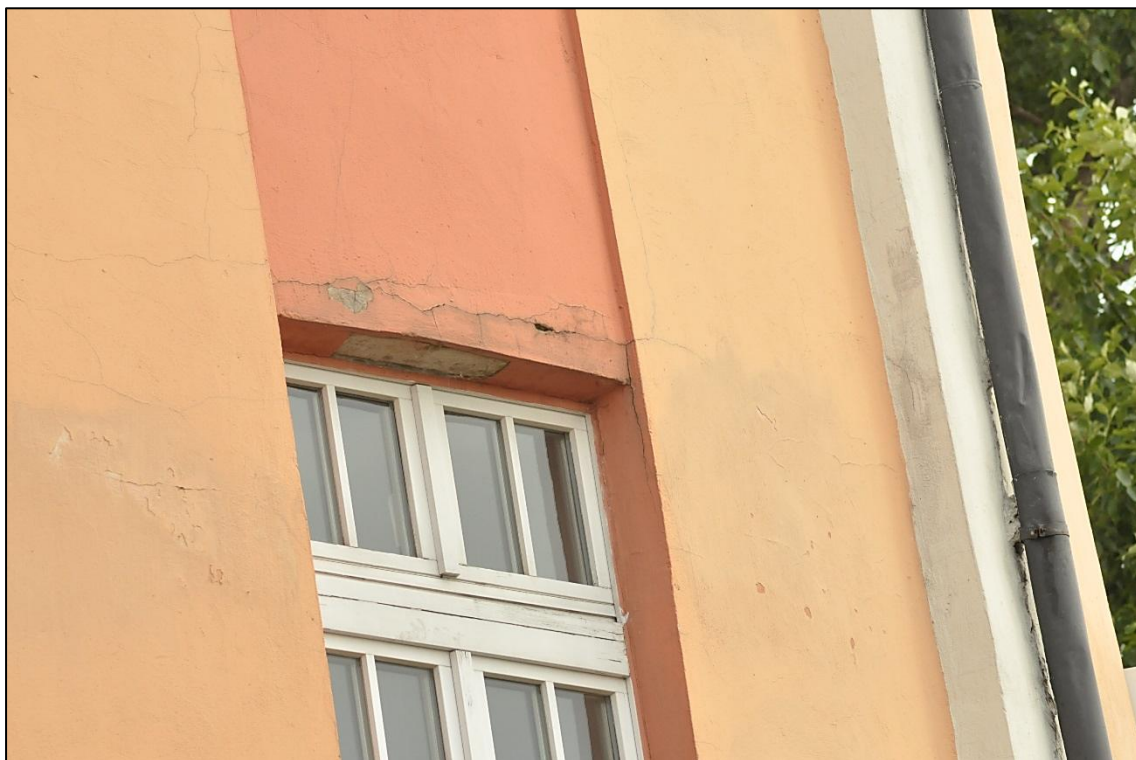
Fot. 9. WIEŻA CIŚNIENÍ, nadproże okna w kondygnacji I piętra od strony płn.-zach. Widoczne pęknięcia i rozwarstwienia tynku na stalowej belce nadproża.
