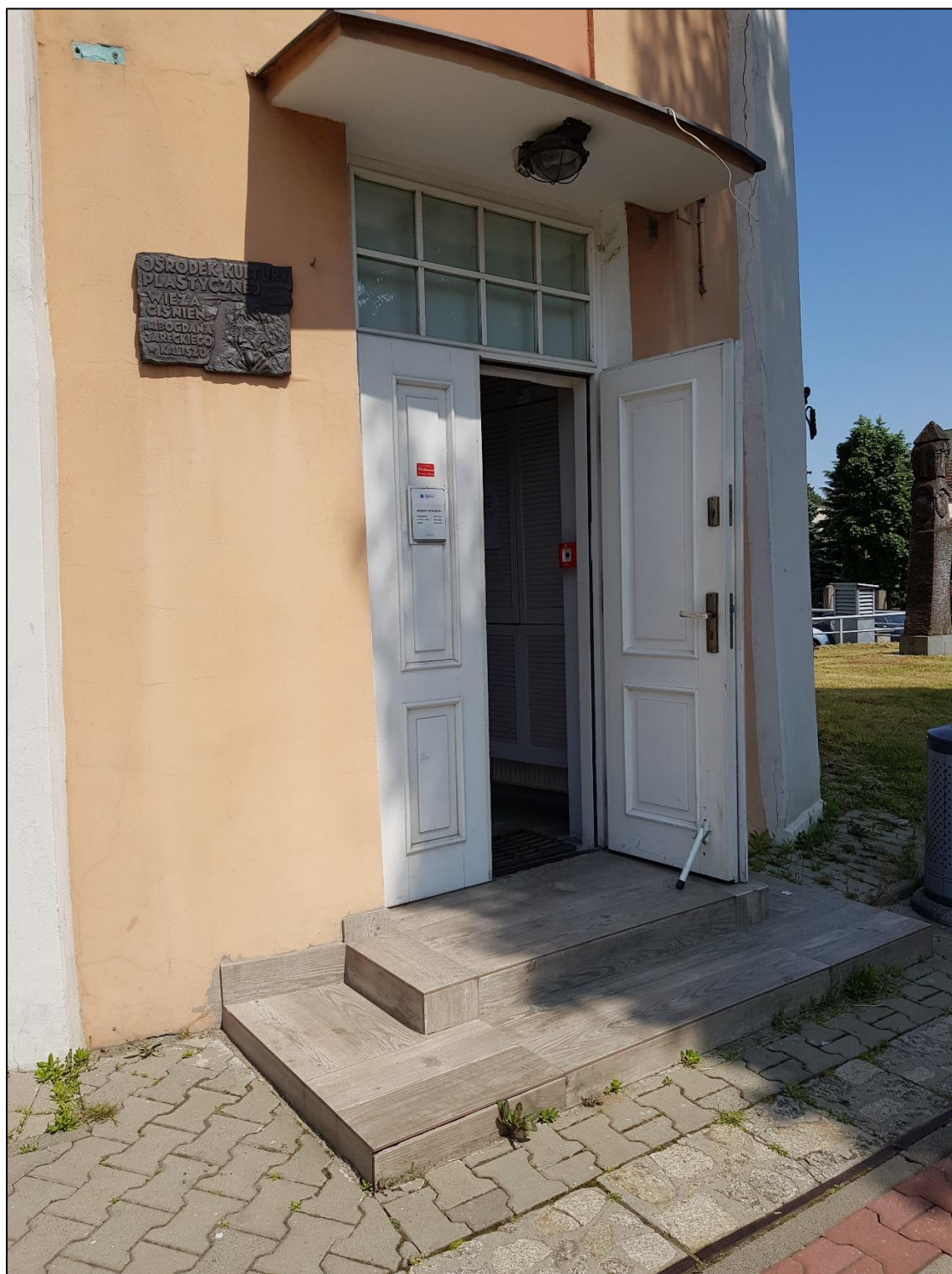
Fot. 7. WIEŻA CIŚNIENÍ, stan z maja 2023. schody i drzwi prowadzące do wnętrza. okładzinę schodów proponuje się zastąpić płytami granitowymi.
