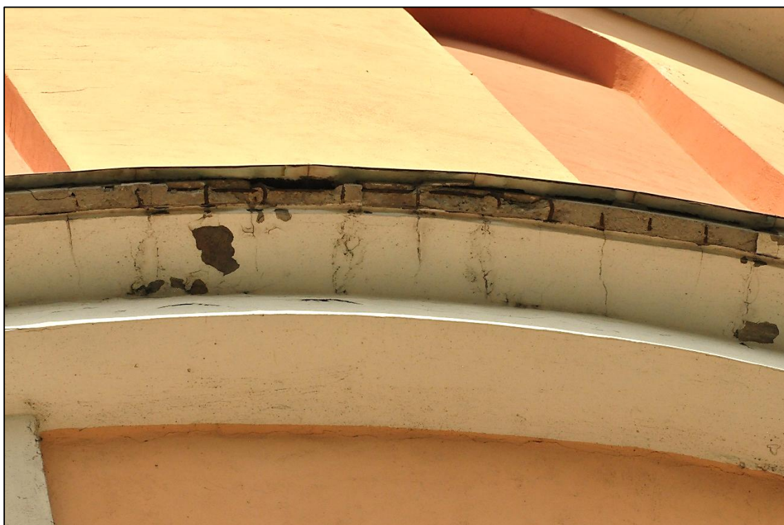
Fot. 13. WIEŻA CIŚNIEŃ, fragment wieńca pod zadaszeniem posadowienia głowicy od strony pld.- zach. Korozja prętów zbrojeniowych spowodowała rozwarstwienia, pęknięcia i znaczne ubytki tynku.
