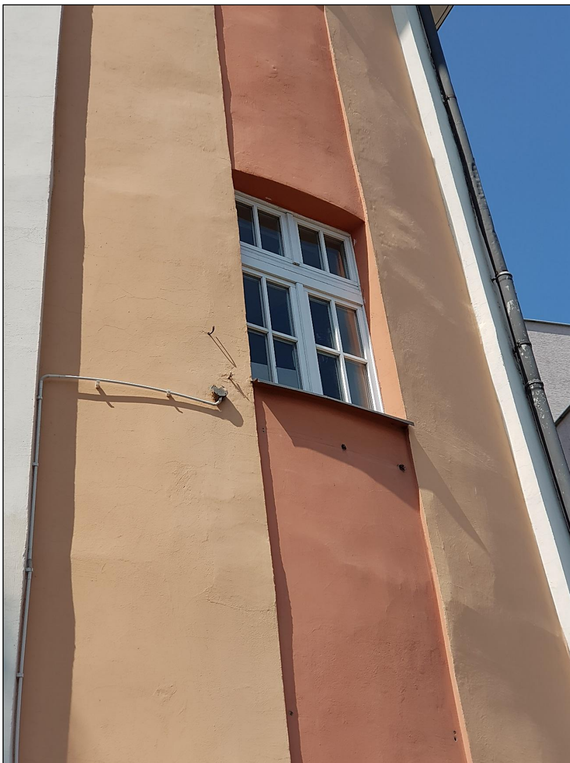
Fot. 8. WIEŻA CIŚNIEŃ, fragment trzonu od strony ul. Legionów. widoczne liczne zniekształcenia, wybrzuszenia powierzchni spowodowane wewnętrznym rozwarstwieniem tynku.
