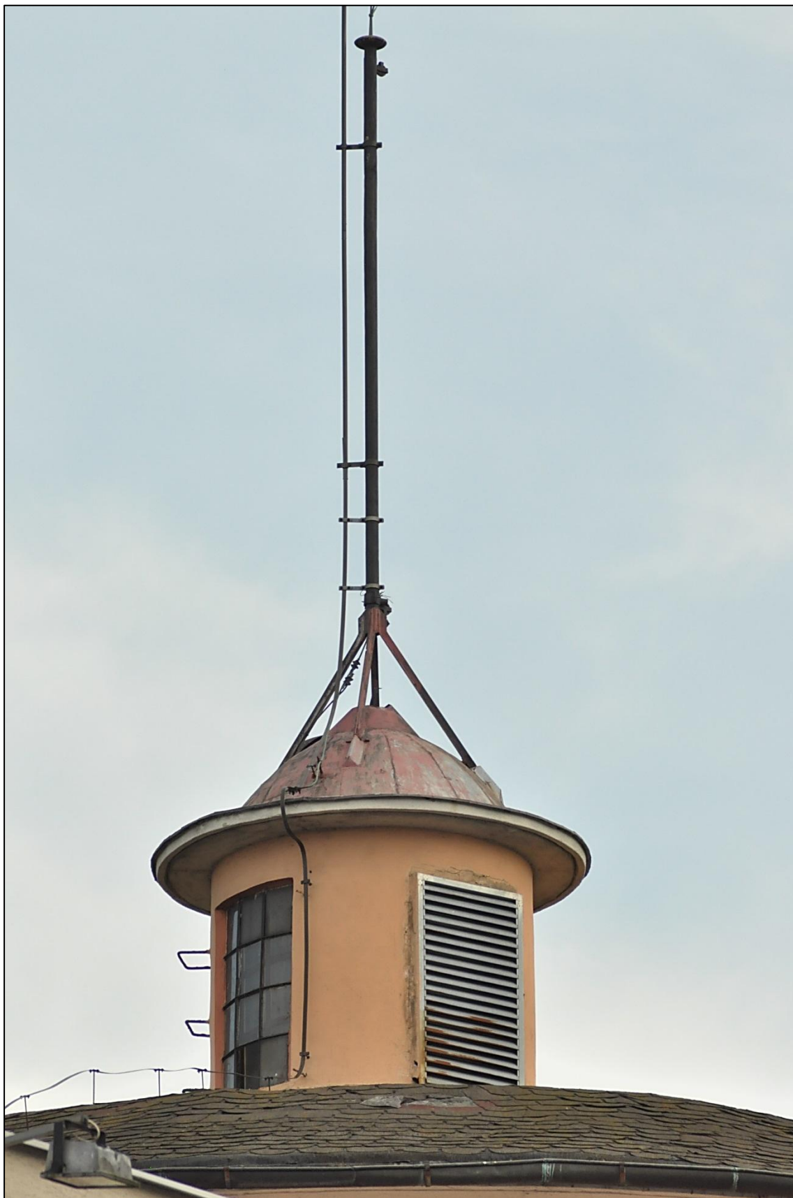
Fot. 16. WIEŻA CIŚNIEŃ, latarnia na głowicy widok od płn.- wsch.. Widoczny fragment dachu na kopule głowicy wykonany z gontu papowego zniszczone, pokryte warstwą porostów. Pokrycie dachowe wieżyczki wykonane z blachy posiada dziwny kształt kopuły zakończonej stożkiem gdzie pierwotnie forma daszku oparta była na stożku a iglica była przedłużeniem stożka.
