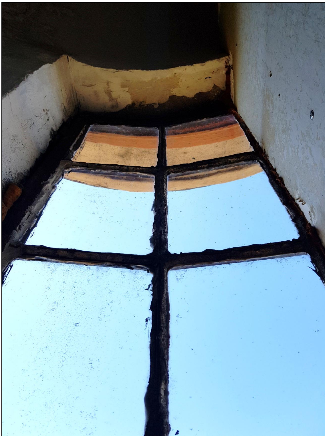
Fot. 18. WIEŻA CIŚNIEŃ – fragment metalowego okienka latarni – jedyne zachowanego pierwotnego okna. okno zachować i poddać konserwacji.
