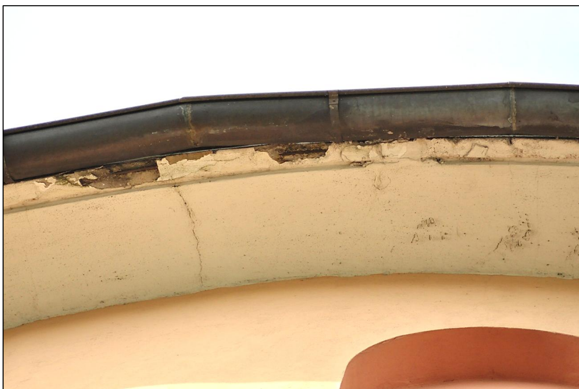
Fot. 14. WIEŻA CIŚNIEŃ, fragment wieńca pod kopulastym zadaszeniem głowicy. Korozja prętów zbrojeniowych spowodowała znaczne zniszczenia krawędzi gzymsu.
