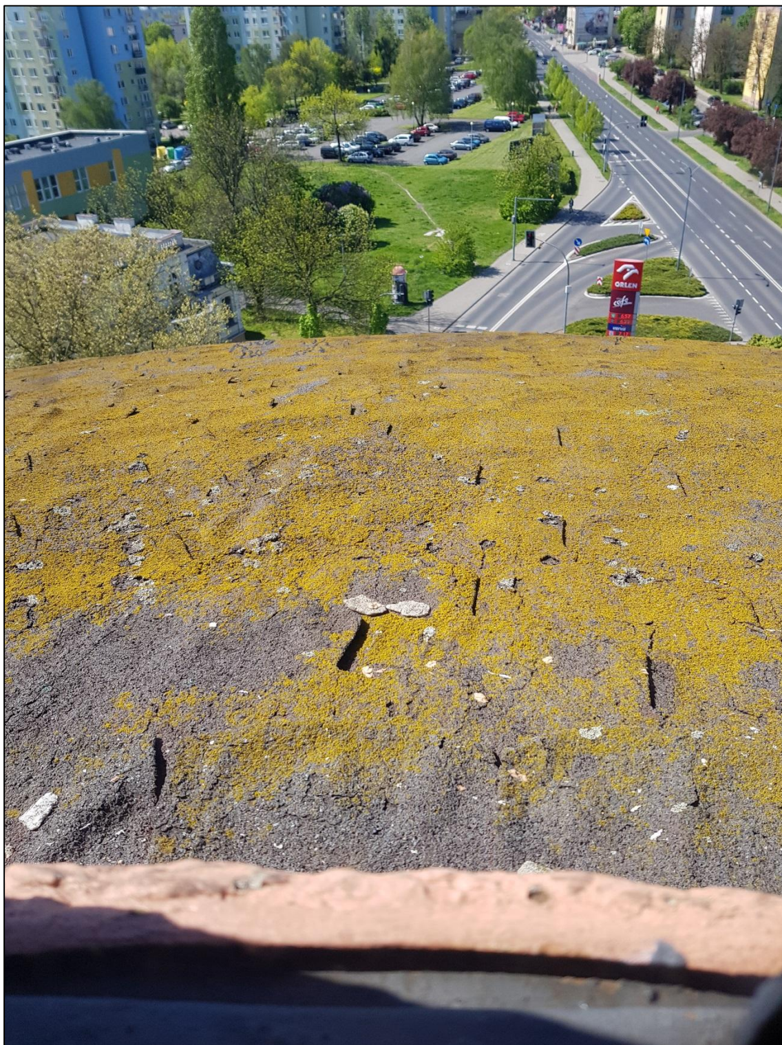
Fot. 17. WIEŻA CIŚNIENÍ - widok z góry pokrycia kopulastego dachu głowicy. widoczny stan zachowania.
