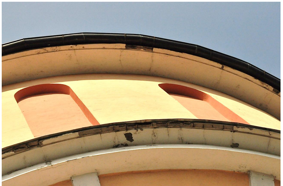
Fot. 11/12. WIEŻA CIŚNIENÍ, fragment głowicy od strony płd.- zach. – zbliżenie. widoczne rysy i poziome pęknięcia tynku w górnej strefie głowicy. Zjawisko to wymaga oceny konstruktora; być może jest efektem korozji przypowierzchniowych elementów zbrojenia jak na fotografii poniżej gdzie korozja zbrojenia spowodowała ubytki tynku wieńca pod dachem.
