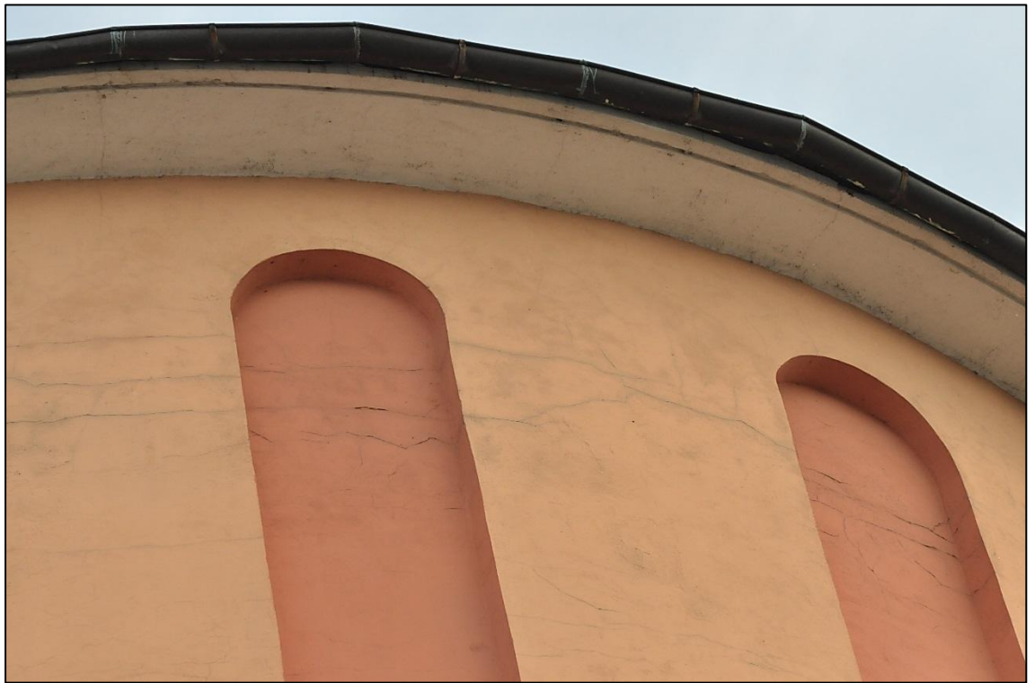
Fot. 11/12. WIEŻA CIŚNIENÍ, fragment głowicy od strony płd.- zach. – zbliżenie. widoczne rysy i poziome pęknięcia tynku w górnej strefie głowicy. Zjawisko to wymaga oceny konstruktora; być może jest efektem korozji przypowierzchniowych elementów zbrojenia jak na fotografii poniżej gdzie korozja zbrojenia spowodowała ubytki tynku wieńca pod dachem.
